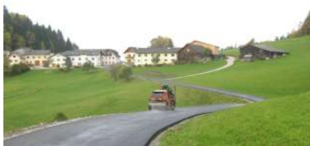
Die Güterwege von Glashütten nach Anschau und wie schon erwähnt der Güterweg Kollegg (Beneder bis zum Haus Gölb) wurden in einer Länge von 1,9 km mit einer zusätzlichen Frostschuttschicht und einer neuen Asphaltdecke versehen.
