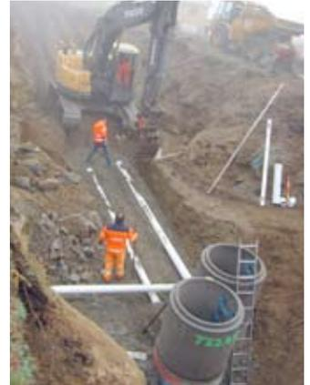
In Dietmanns wurde mit dem Bau des Löschwasserbehälters begonnen. Der Behälter wurde betoniert und die Dichtheitsprüfung durchgeführt. Es wurde ein Überlauf gegraben und das Grundstück rekultiviert. Die Arbeiten konnten heuer noch abgeschlossen werden.
