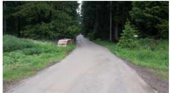
Auf rissigen bzw. ausgemagerten Asphaltdecken wurde eine selektive Oberflächenspritzung (Fleckerlteppich) aufgebracht. Dies erfolgte auf dem Güterweg Weidenegg - von Kolleg, Winkl bis Dornhof.
